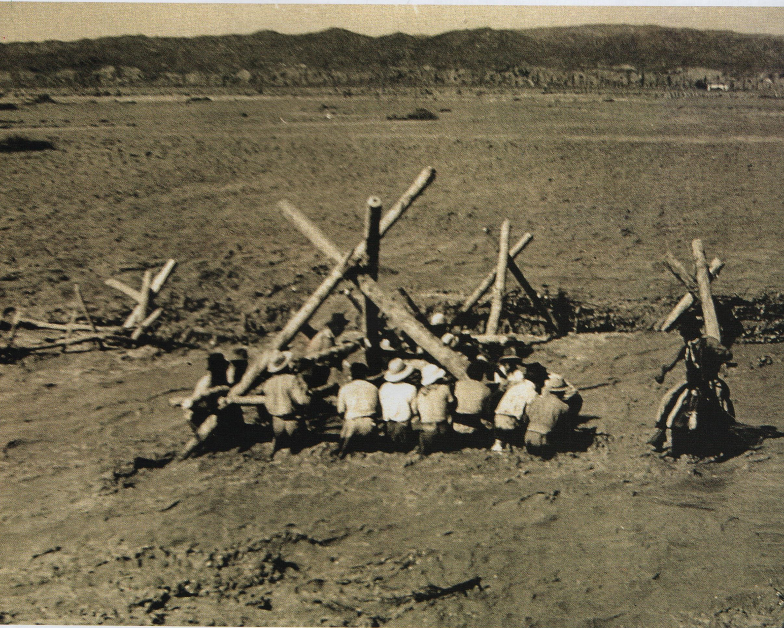
Trabajos de colocación de un "pié de gallo" durante una creciente en el río Mendoza.
