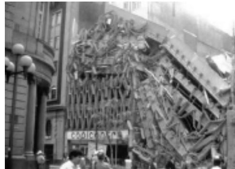
Si aparece una grieta, ésta se cierra y se abre repetidamente, produciéndose choques entre sus dos caras cada vez que se cierra, estos choques machacan fácilmente cualquier material. Los techos, sobre todo los que abarcan grandes áreas pueden desplomarse por su parte central.
