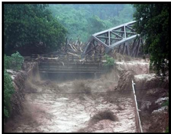
Encallamiento del puente ferroviario sobre el primer puente carretero.
