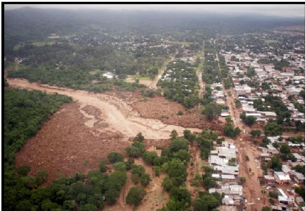
Cauce desbordado del río Tartagal y puente ferroviario arrastrado hacia la avenida Packham.
