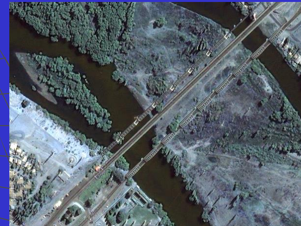
IKONOS Puente ferroviario-Cipolletti
