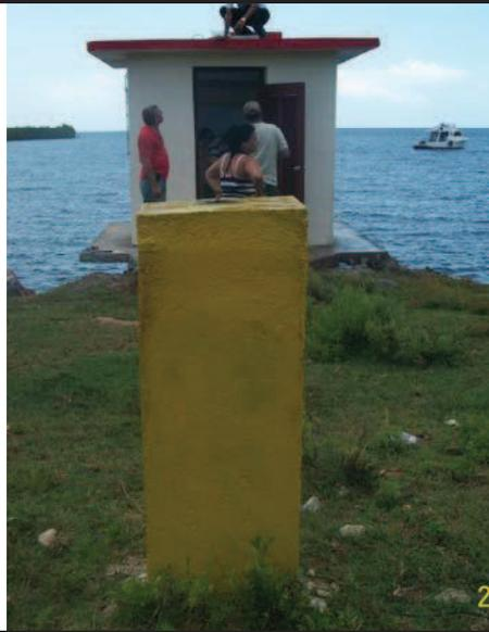
Monumento de centración forzada estación Los Morros, para mediciones con GPS y chapa de trabajo del mareógrafo.
