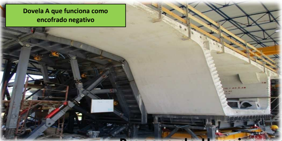
Desencofrado de la Dovela B
