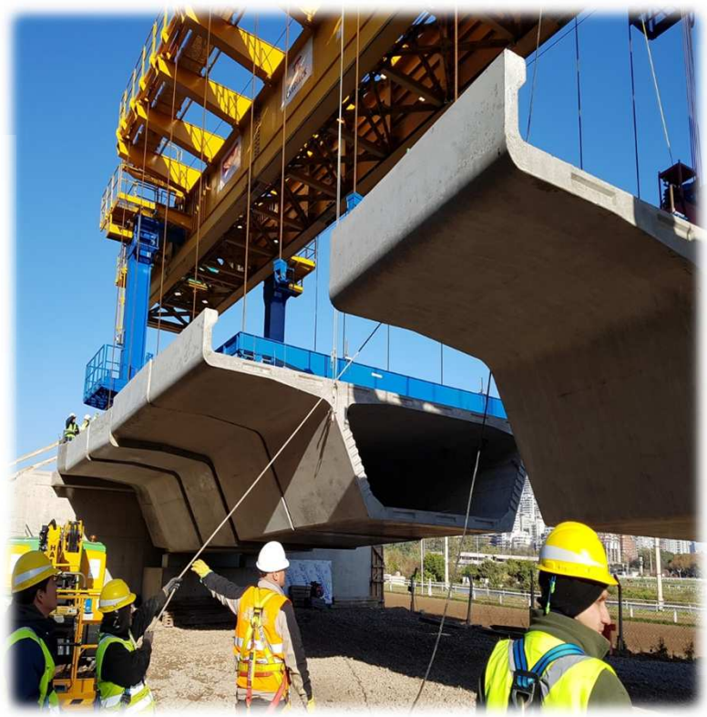
Viga Lanzadora soportando las Dovelas desde la Viga Principal
