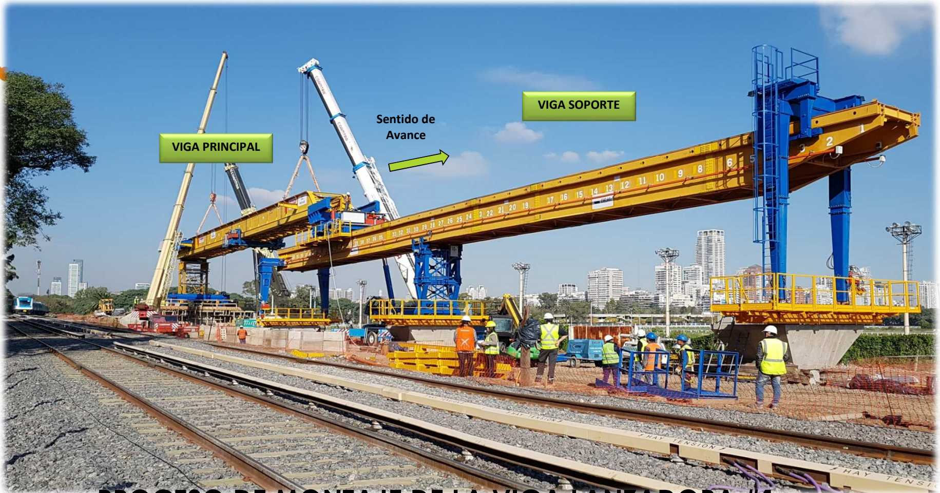
PROCESO DE MONTAJE DE LA VIGA LANZADORA #1
