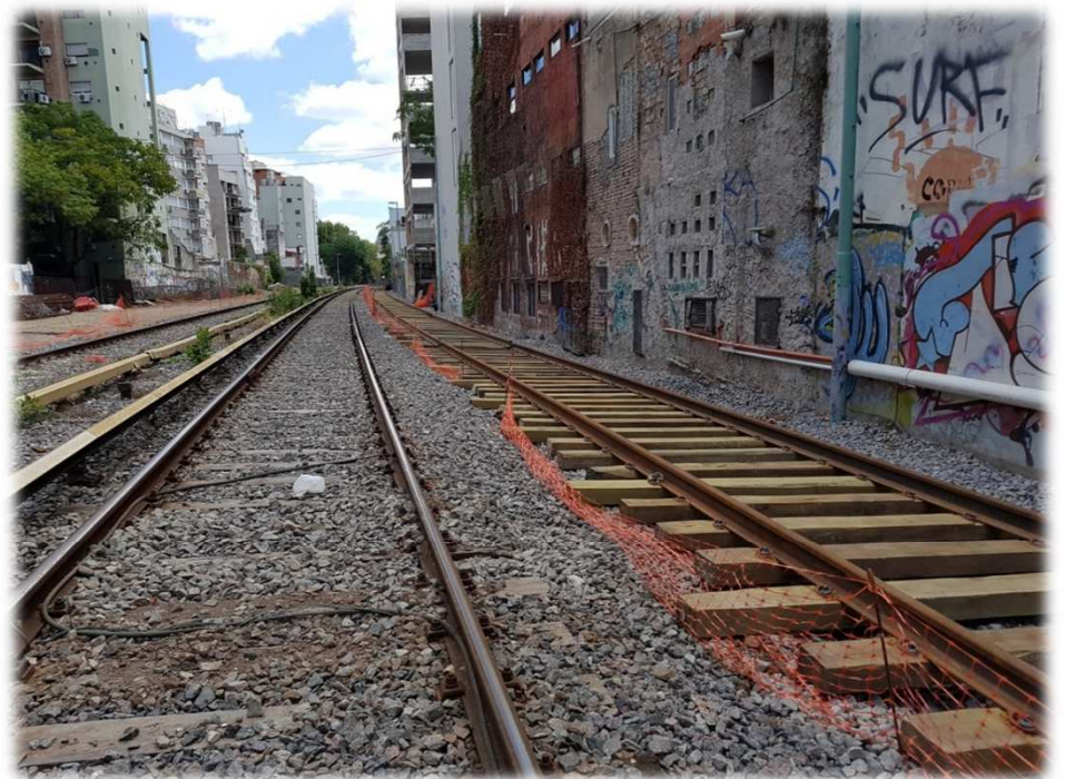
Vía Provisoria en Ejecución
