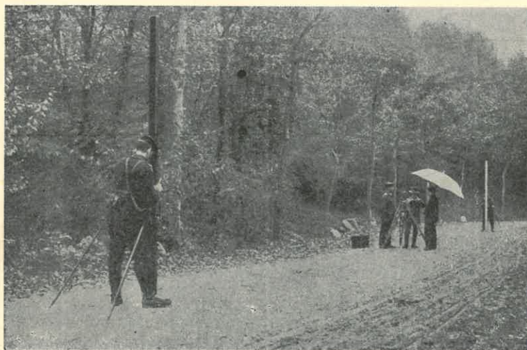
Fig. 1. — Se ilustra la ejecución de la nivelación de precisión.
