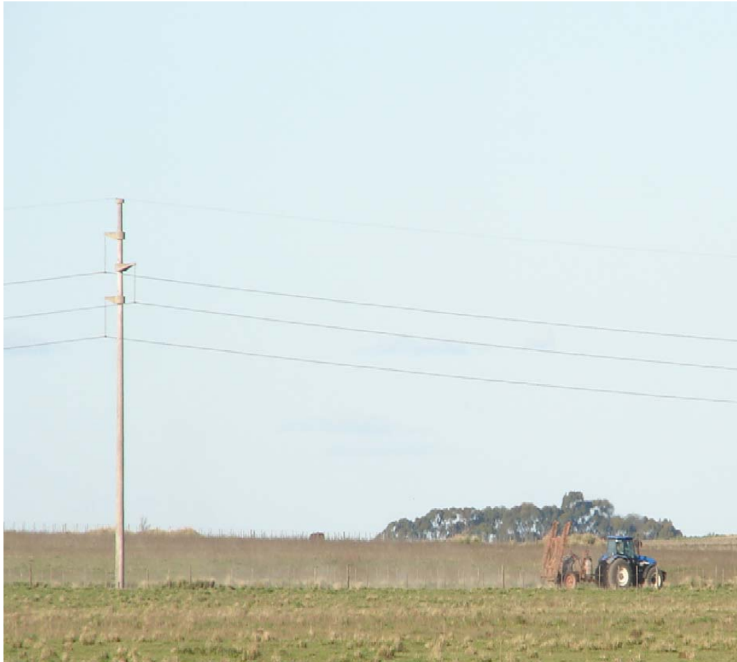
Línea de alta tensión que afecta a la parcela 799a
