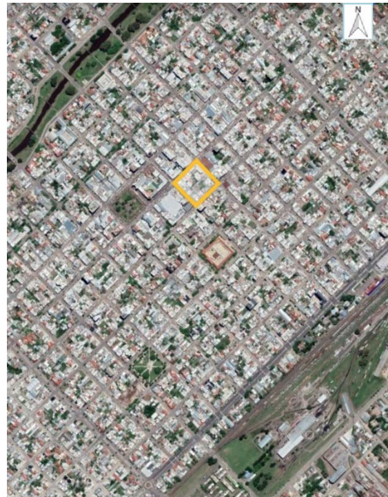
Fig. 3 Ubicación de la obra en el microcentro de la ciudad de Olavarría. Fuente: elaboración propia.
