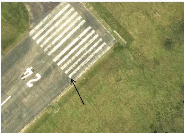
Ilustración: Pintura de la pista, lado del río.
