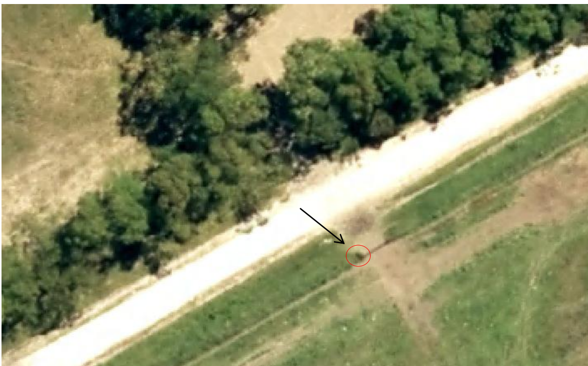
Ilustración: Poste de tranquera, camino de acceso a BAPI.
