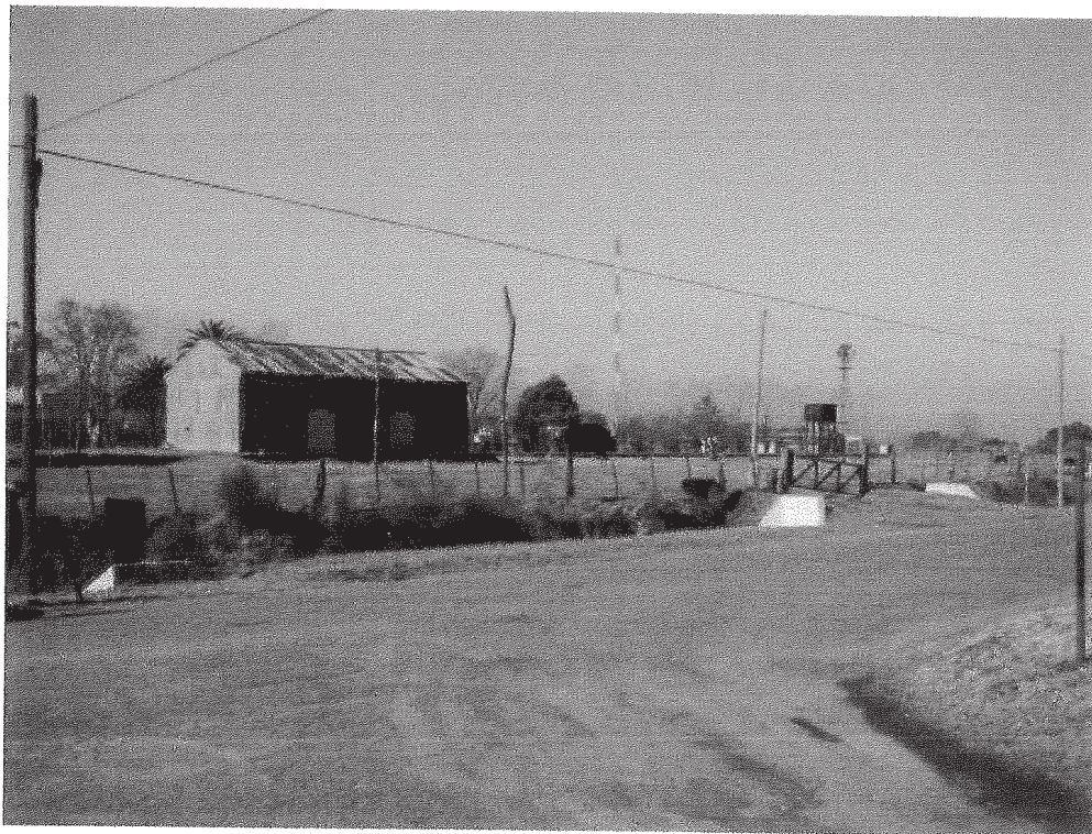
Estación de Oliden
