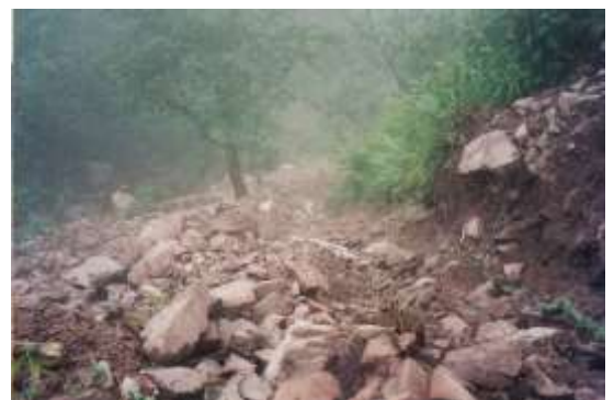
Figura 2: Bloques caídos por gravedad
