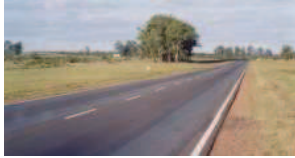
Árboles afectados por la futura obra
