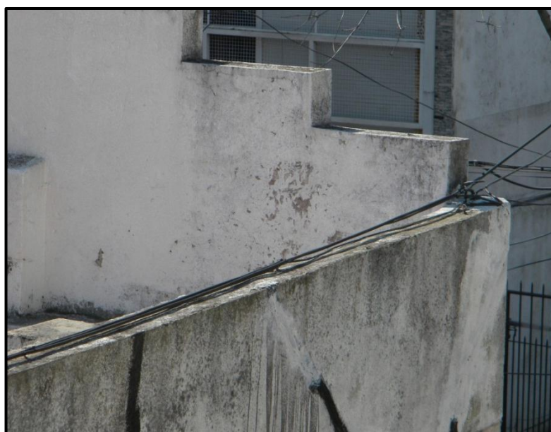
Foto 5.3.1. Muro de Parapeto en Azotea
