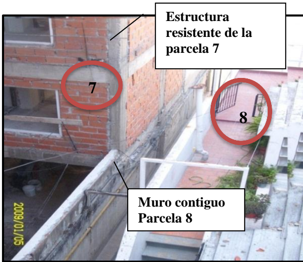
Foto 11.6. Vista del pasillo
