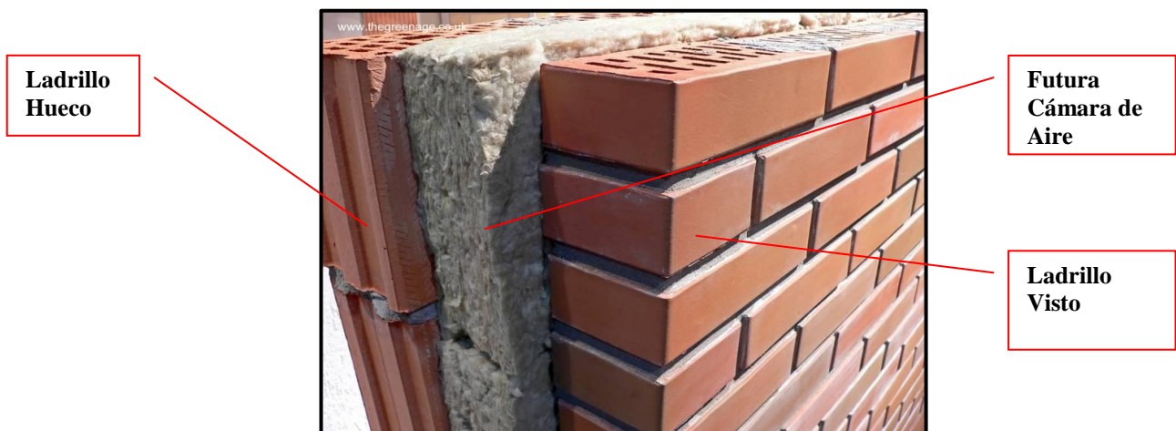
Figura 5.5.4. Muro con cámara de aire. Fuente: http://www.sistematicasa.com.ar
