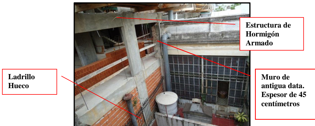
Foto 5.5.3. Estructura de Hormigón, empotrado en Muro Medianero
