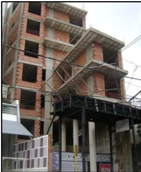
Foto 5.5.1. Edificio con Estructura de H° A°
