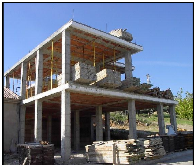
Foto 5.5.2. Estructura de H° A°
