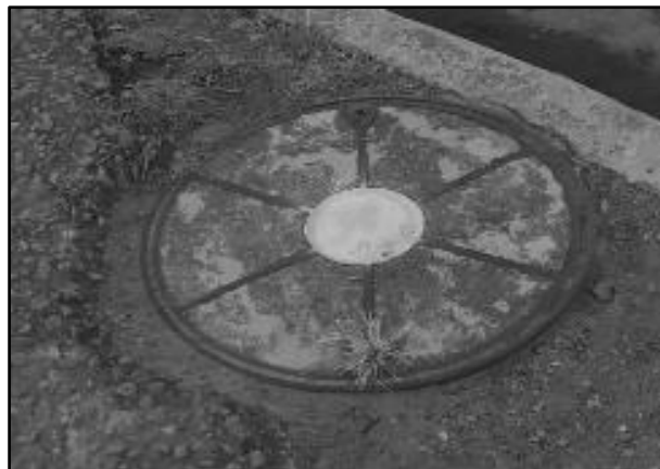
Figura 20. Punto de Apoyo Fotogramétrico. Fuente: Elaboración propia.
