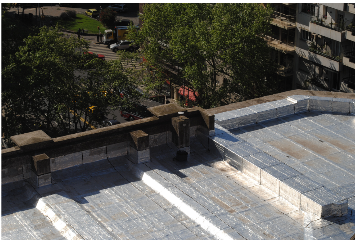
Figura 5.3: Vista elevada de FI04.
