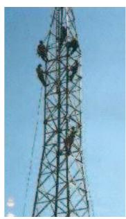
Las torres construidas con estructuras metálicas, se van armando pieza por pieza como si fuese un "mecano".
