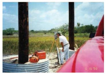
Es en este momento donde el agrimensor juega un papel muy importante puesto que si por ejemplo los conductores quedasen sobre tensados, correrían el riesgo durante la época invernal, con las bajas temperaturas, al contraerse los mismos, de provocar la rotura y hasta el arrancamiento de una estructura.
