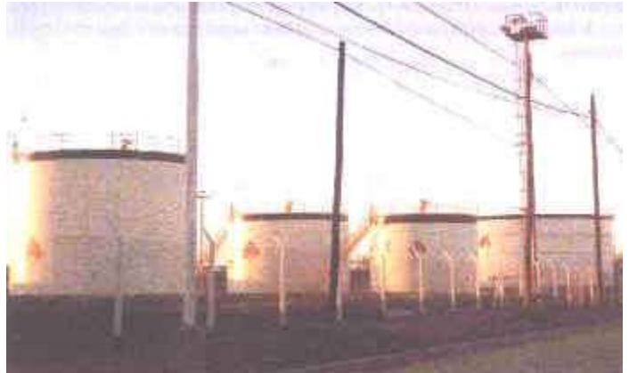
Figura 5: Planta de almacenamiento de petróleo en Formosa
