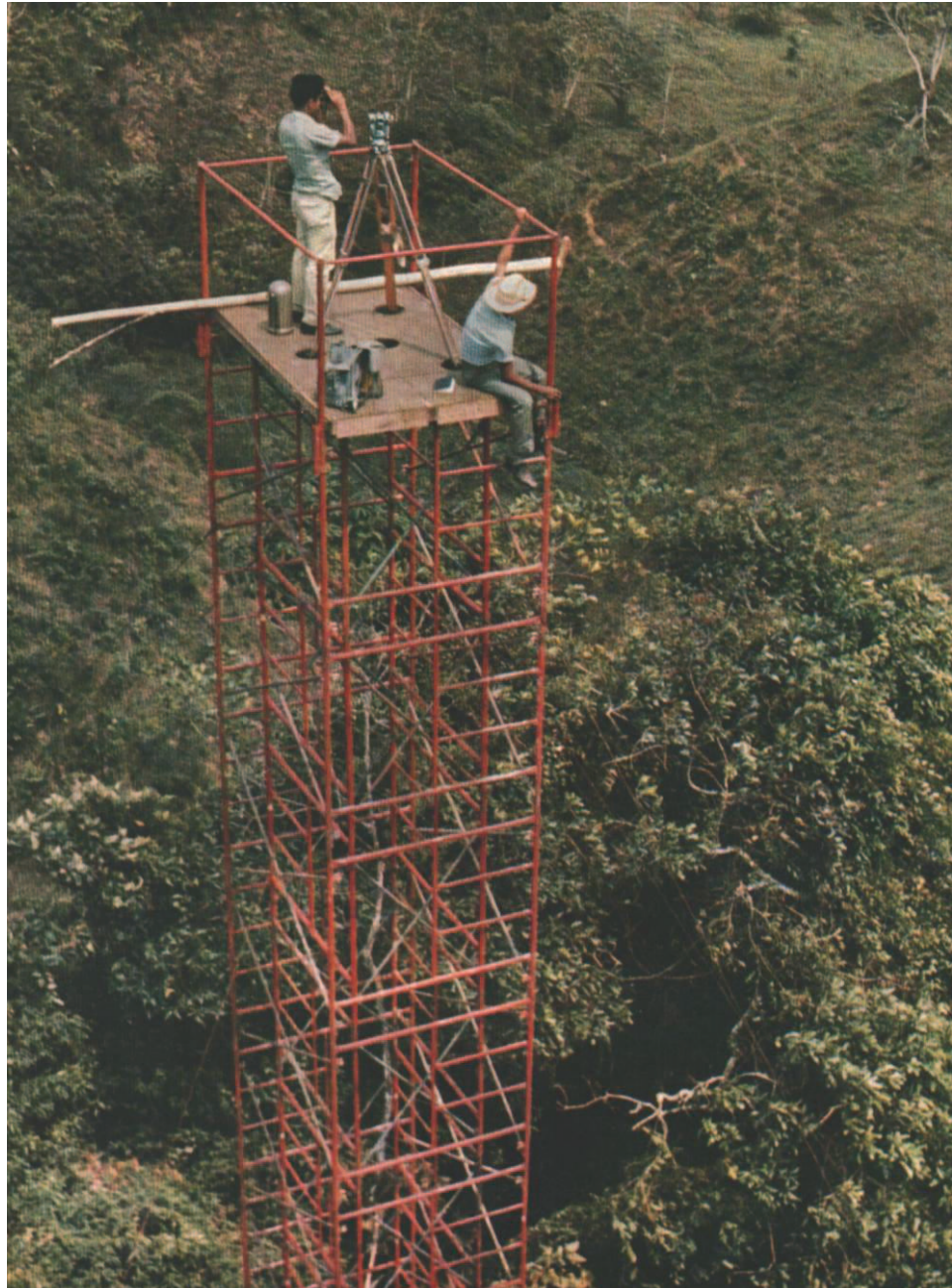
Fig. 184 Torre utilizada para triangulaciones. El apoyo del teodolito es independiente del que se usa el operador
