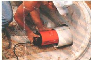
*El Gradelight se autonivela en el interior de cualquier tubería, sin importar su pendiente.*
