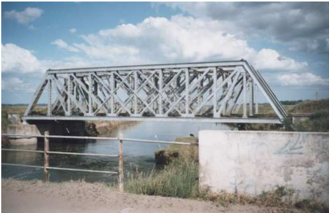
Puente metálico Arroyo Saladillo
