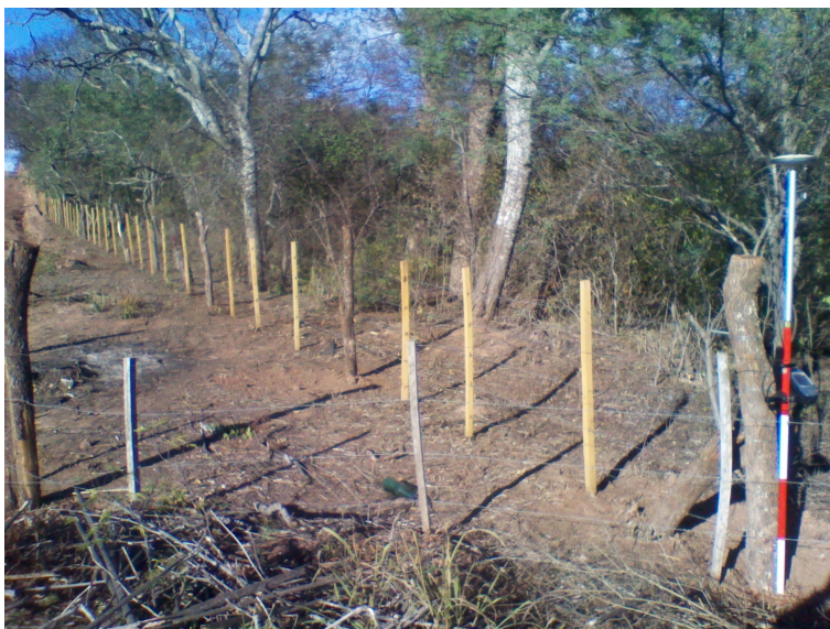
Ilustración 11: Alambrado de la mensura reconstruido, por el mismo lugar del anterior.
